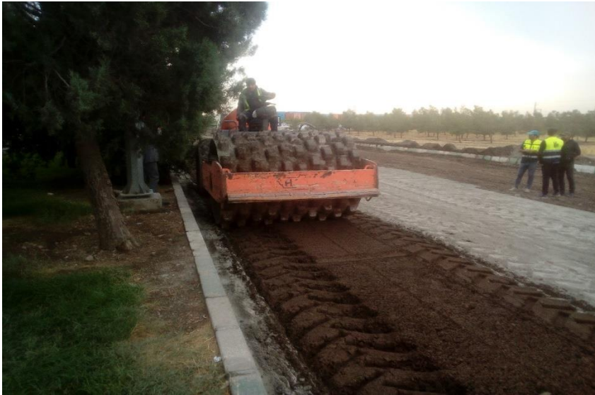
کمپکت نمودن مصالح مخلوط شده با غلطک پاچه بزی به همراه ویبره
