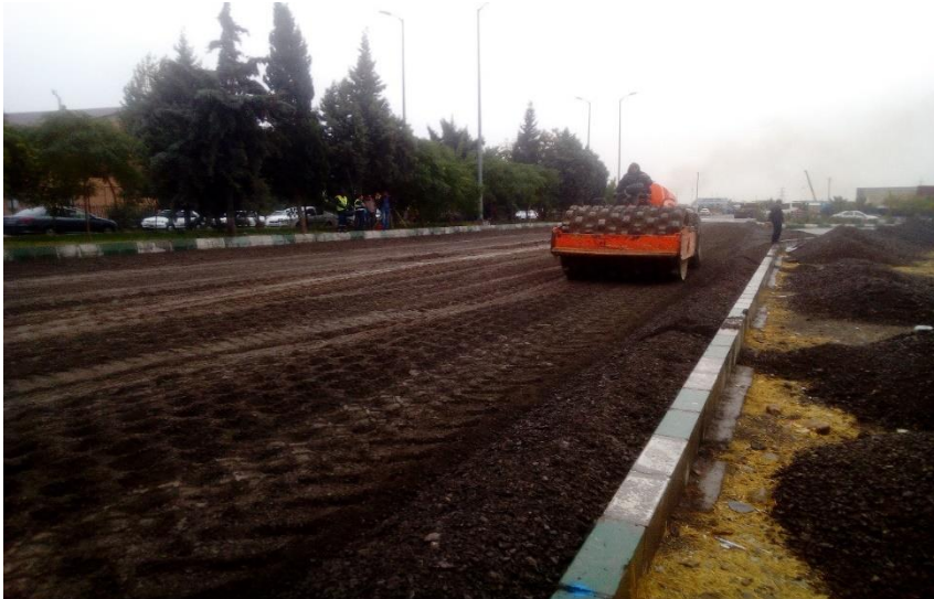
ادامه کمپکت نمودن مصالح مخلوط شده با غلطک پاچه بزی به همراه ویبره
